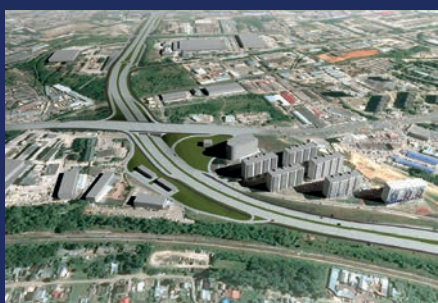
Строительство двух участков Вознесенского тракта в Казани: от ул. Гвардейской до пр. Победы и далее — до автодороги М-7
