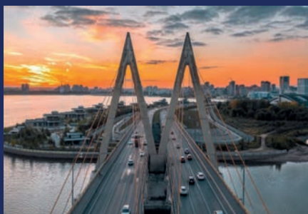
Реконструкция моста Миллениум
